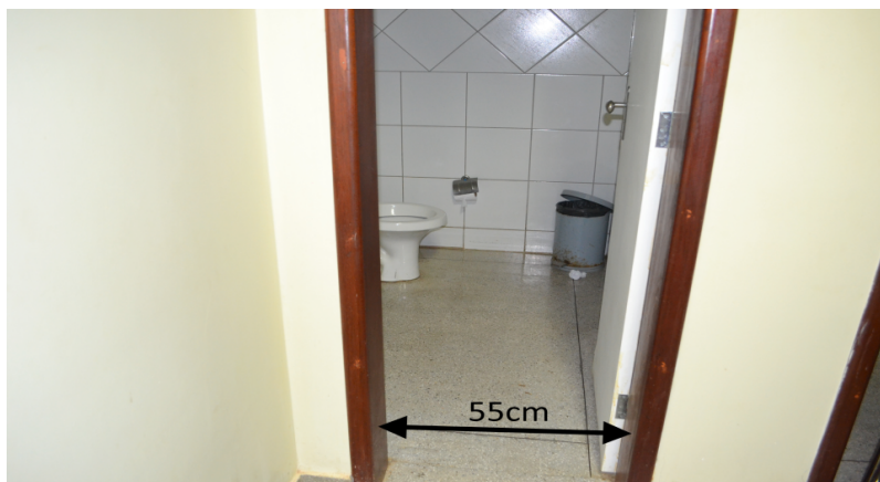
Figura 1 Porta de entrada do banheiro dos servidores
