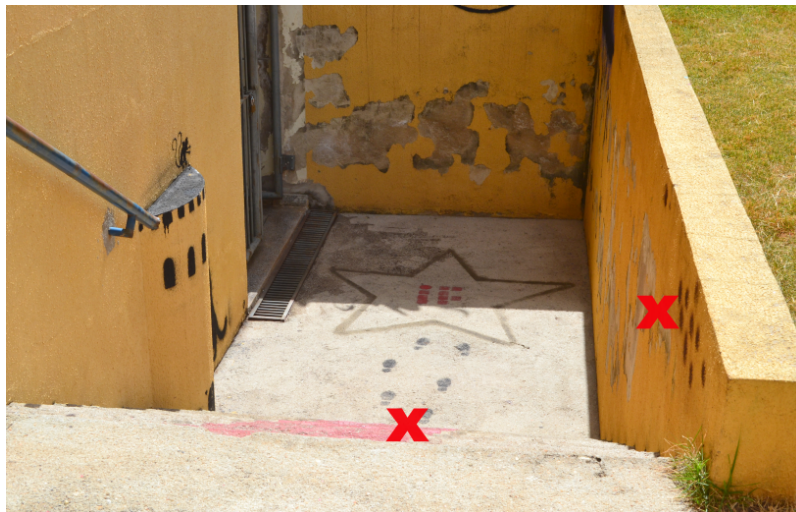
Figura 3 Escadas de acesso à sala de música e artes
